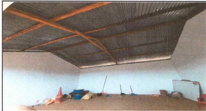
Foto 3: Se observa el deterioro de las laminas portante
